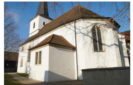
(a) von Südosten
