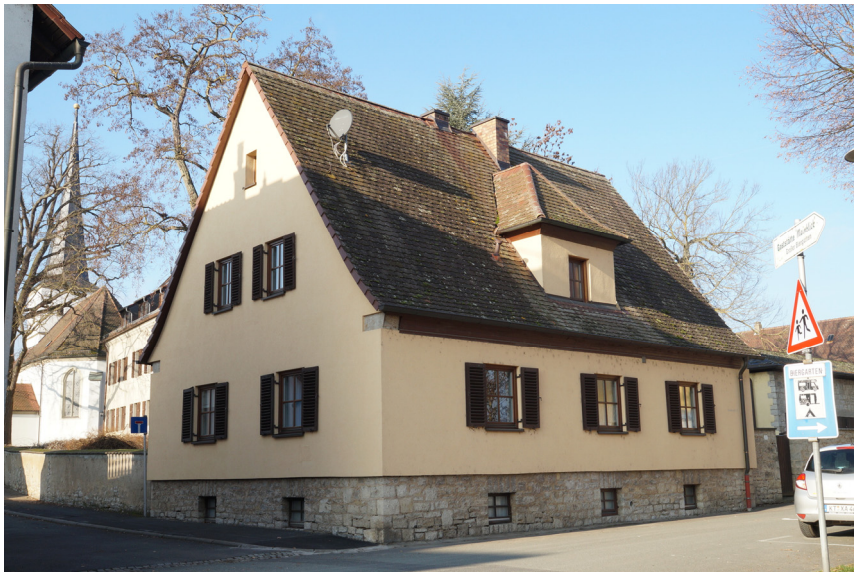
(a) Wohnhaus von Südosten
