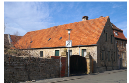
(a) von Südosten
