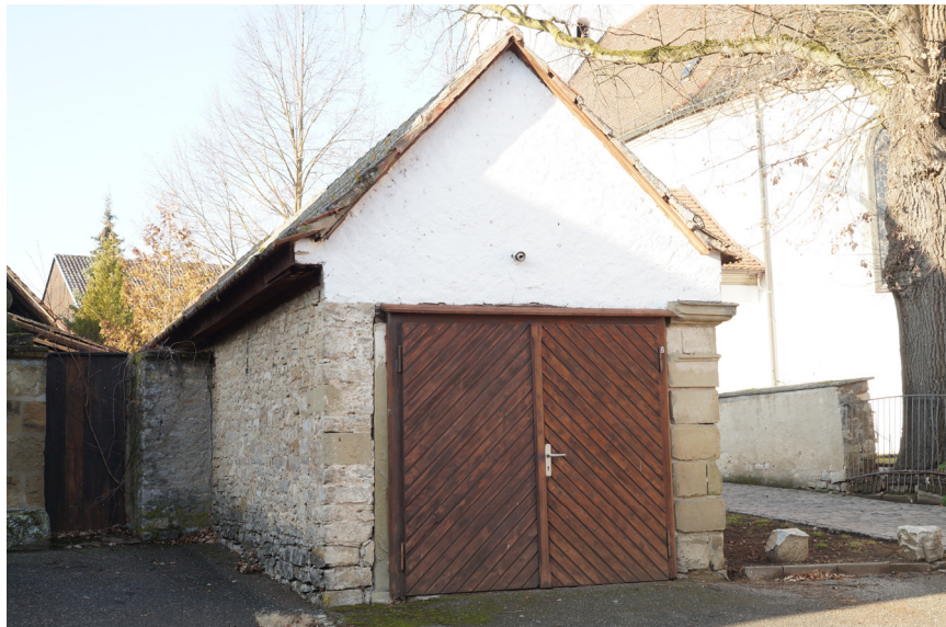
(b) ehem. "Feuerlöschrequisitenhäuschen" von Südosten
