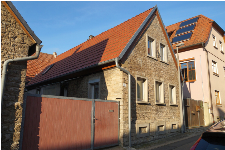
(a) Wohnhaus von Süden
