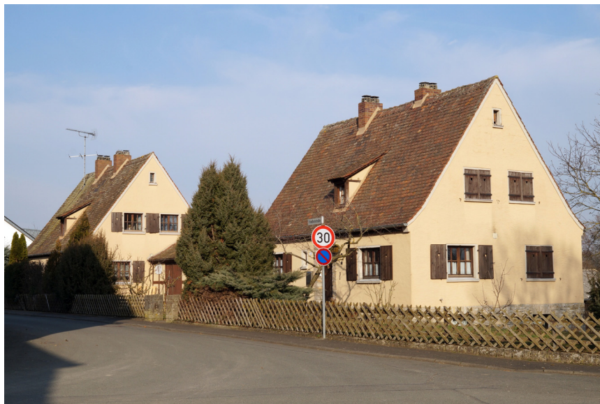
(a) u. (b) Doppelhausanlage von Südwesten
