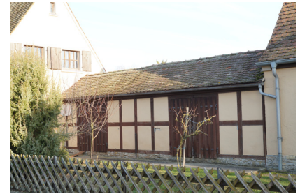
(b) Nebengebäude CR1279
