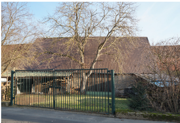
entlang der nördl. Stadtschwarzacher Straße
