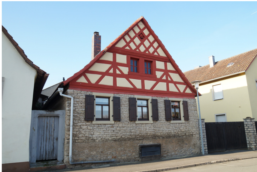
(a) Wohnhaus von Südosten
