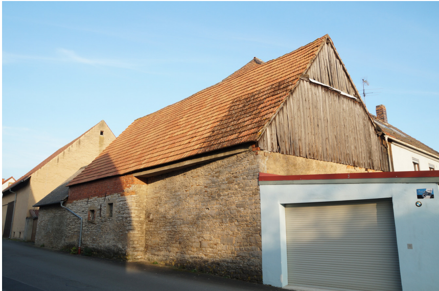
(a) Scheune von Südwesten
