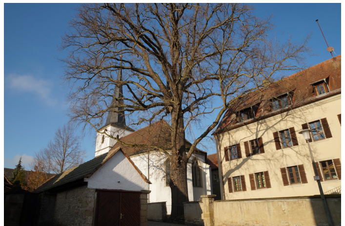
(a) von Südosten
