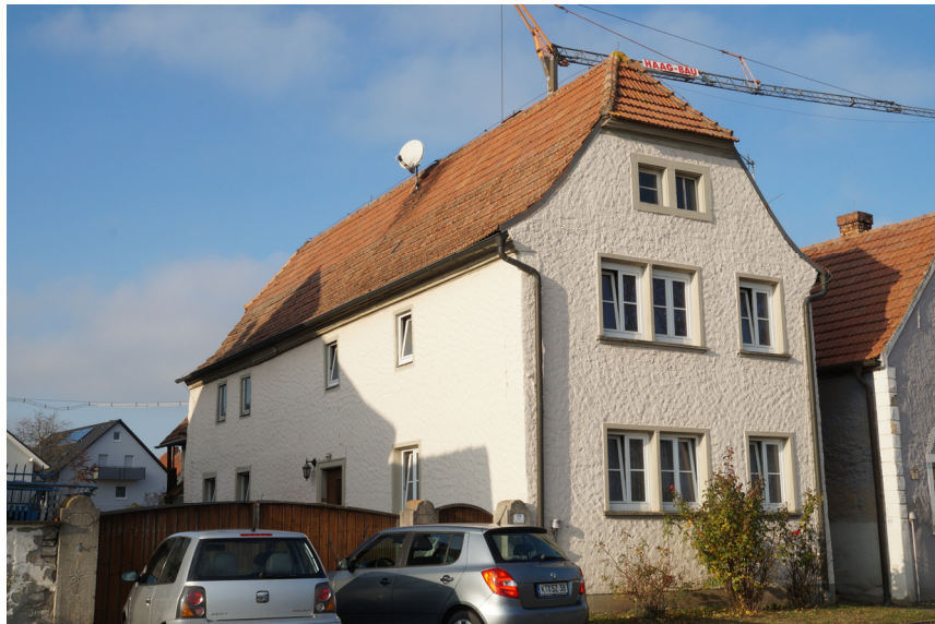
(a) Wohnhaus von Südosten
