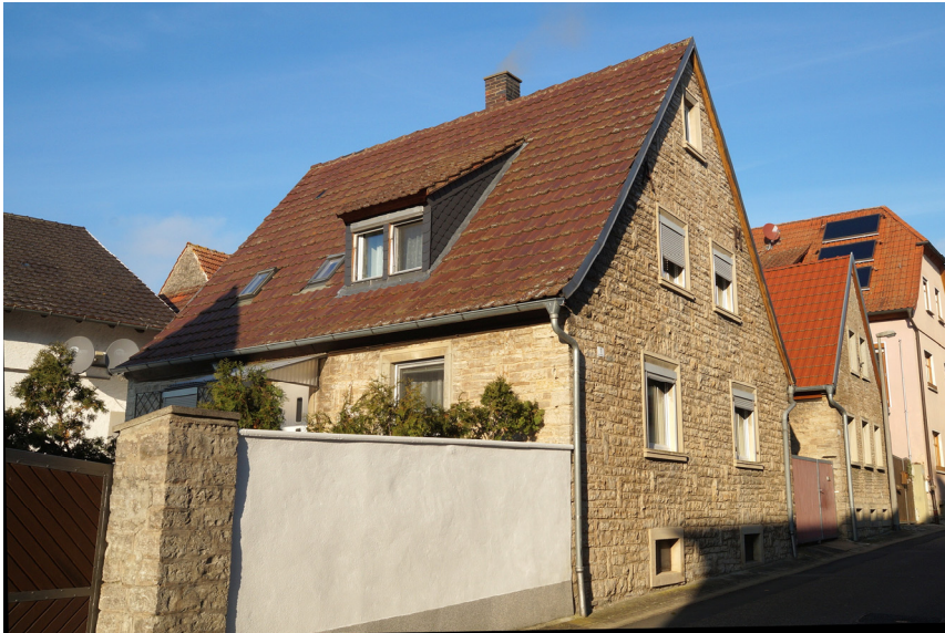
(a) Wohnhaus von Süden
