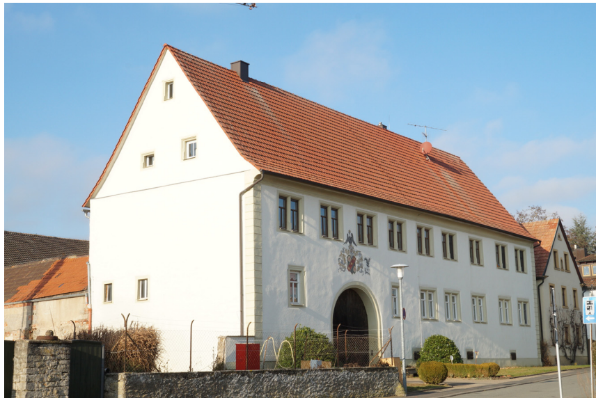
(a) Wohnhaus von Südosten
