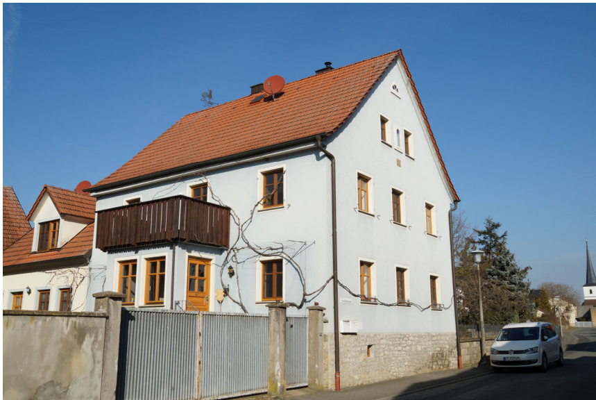
(a) Wohnhaus von Südosten
