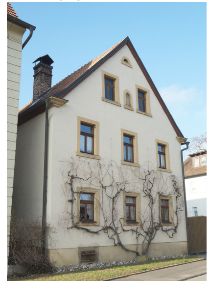
(a) von Südosten
