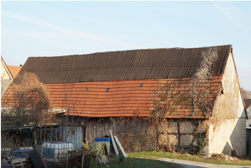
(a) Scheune von Westen
