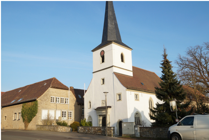
(a) Kath. Pfarrkirche von Südwesten
