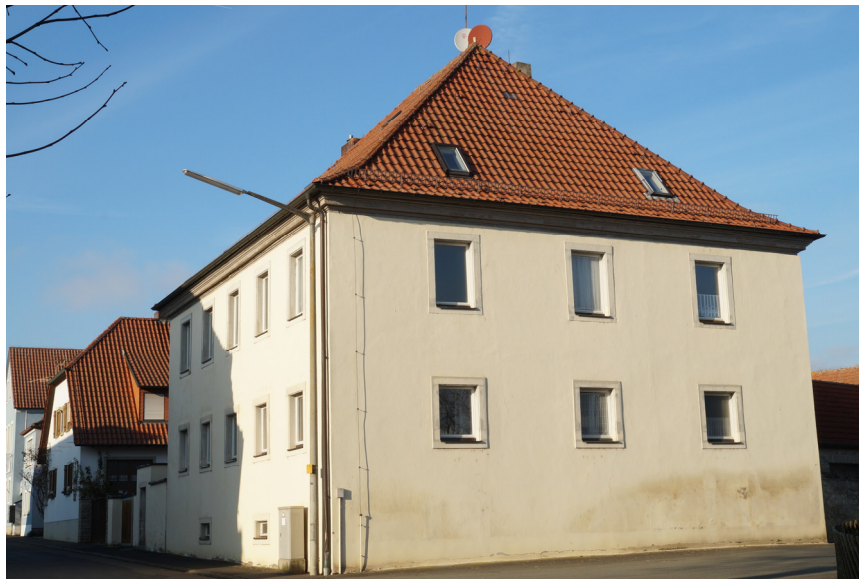
(a) Wohnhaus von Südosten
