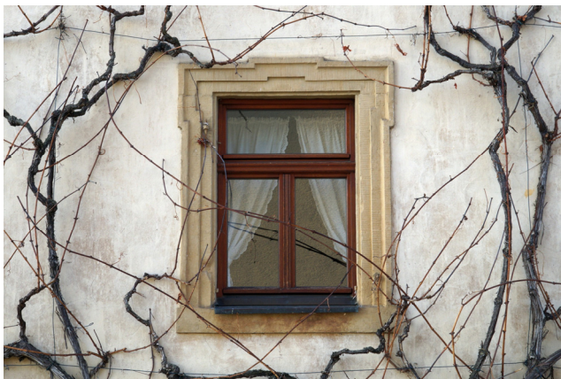
Gewände aus Sandstein (Mainstraße 25)
