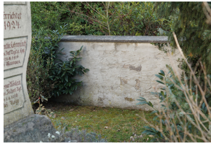
(e) Kirchhofmauer im Süden CR3084
