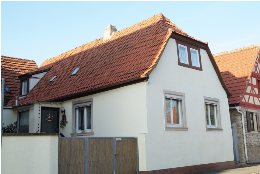
(a) Wohnhaus von Südosten
