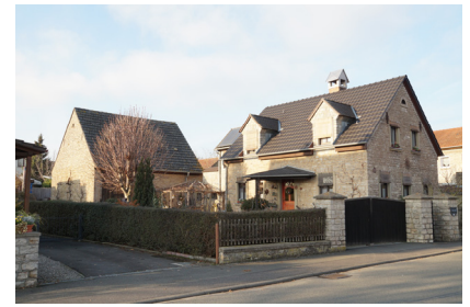
Hofanlage von Südosten
