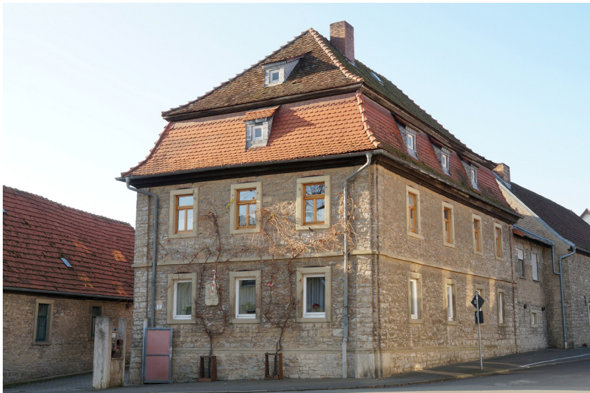
(a) Wohnhaus von Osten
