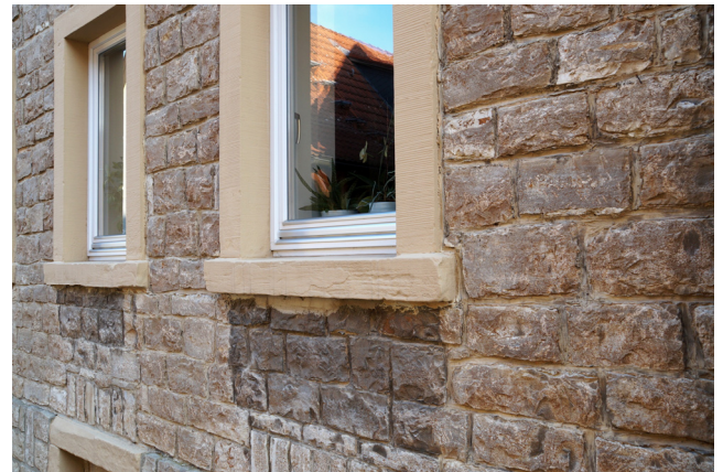
Kalksteinkleinquadermauerwerk (Am Sandhügel 4)
