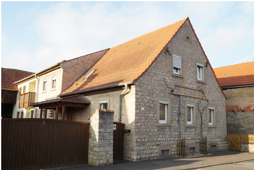
(a) Wohnhaus von Südosten
