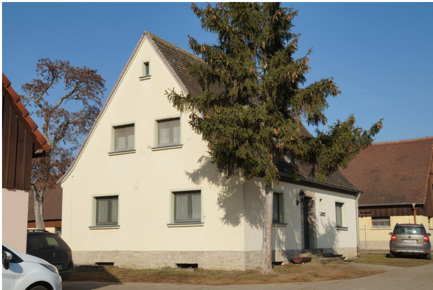
(a) Wohnhaus von Südosten
