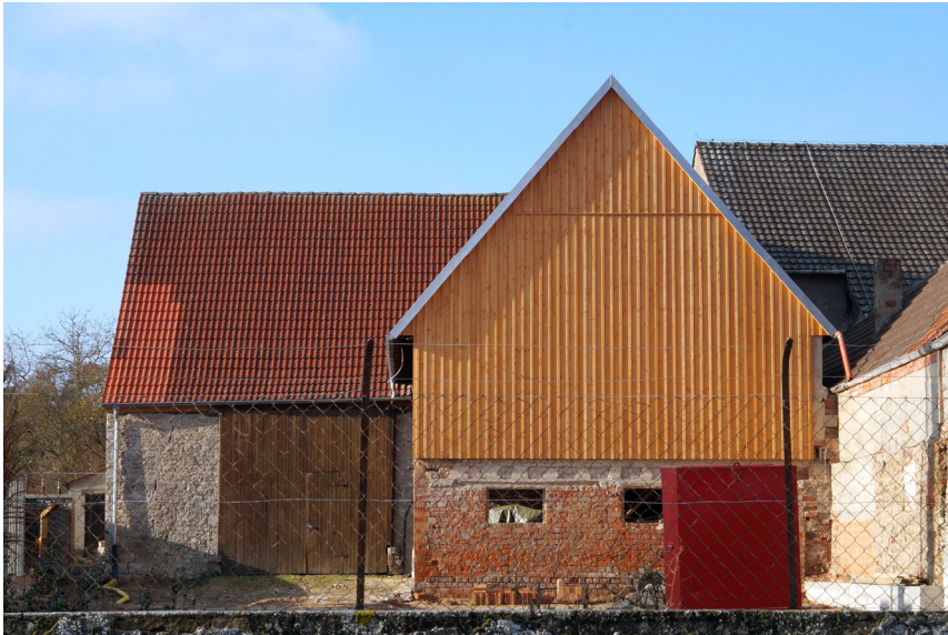
(a) Scheune (im Hintergrund)
