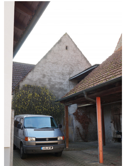
(b) Scheune von Osten
