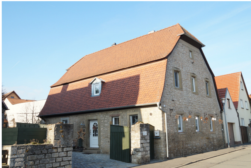
(a) Wohnhaus von Südosten
