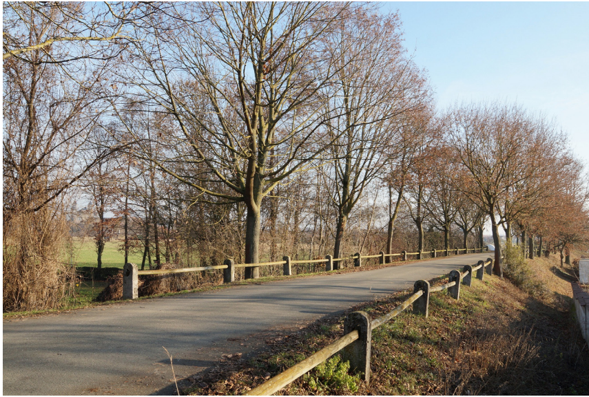
(a) Straßendamm mit (b) Allee nach Osten
