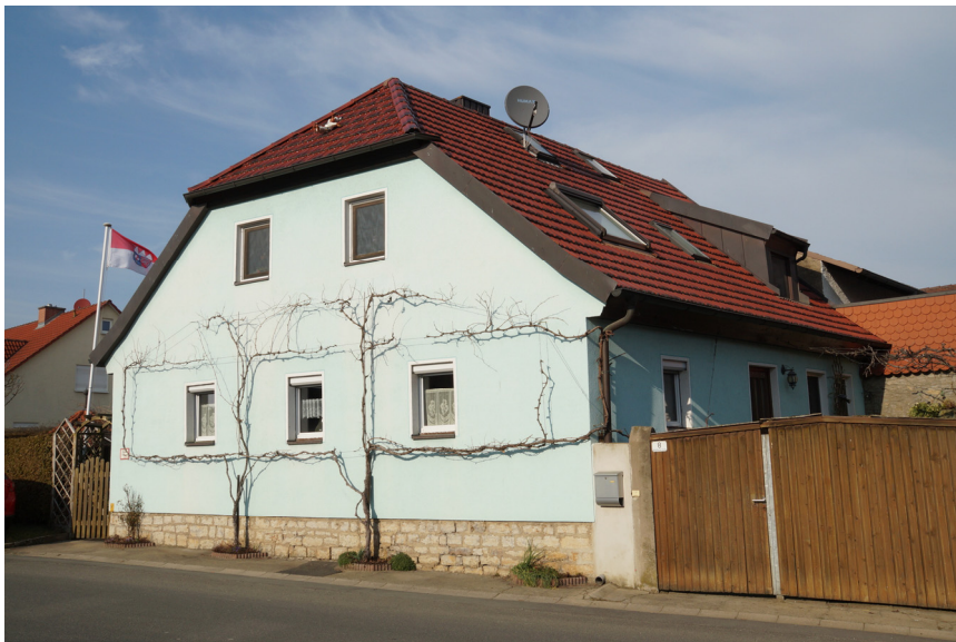
(a) Wohnhaus von Süden
