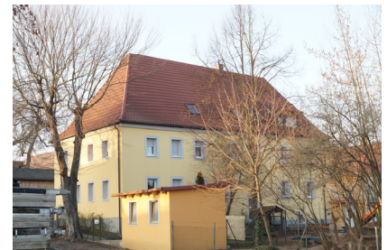
(a) von Südosten
