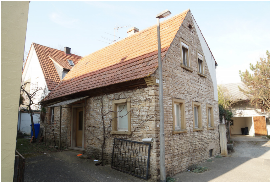
(a) Wohnhaus von Süden
