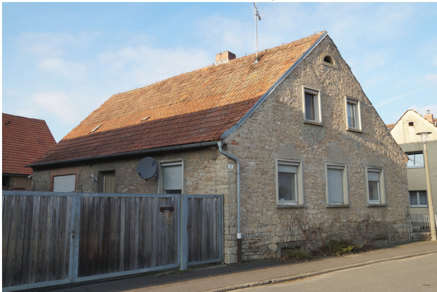
(a) Wohnhaus von Südosten
