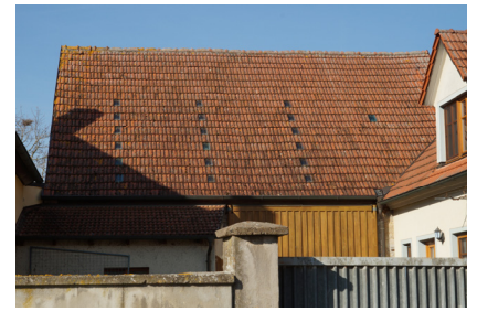
(b) Scheune von Osten
