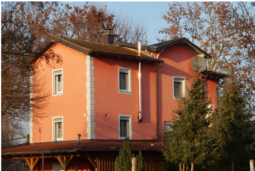
(a) Wohnhaus von Süden
