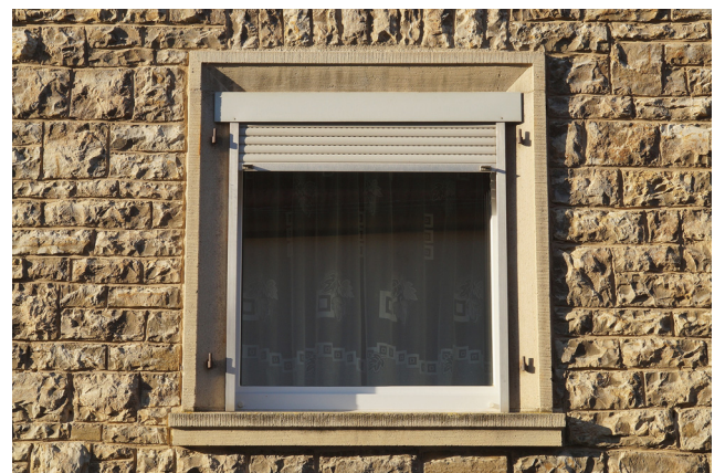
Gewände aus Betonwerkstein (Am Sandhügel 1)
