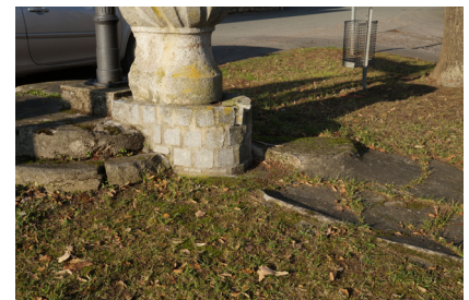
(a) von Südosten
